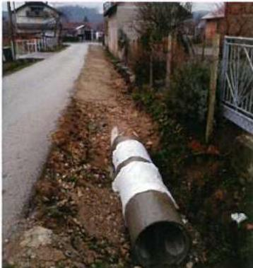
U tijeku su radovi na zacjevljivanju kanala za oborinsku odvodnju u mjestu Slanje, ulica Žrtava fašizma. Također, radi se na ugradnji betonskih kanalica za oborinsku odvodnju u mjestu Vrbanovec, ulica Rudolfa Krušeca.
