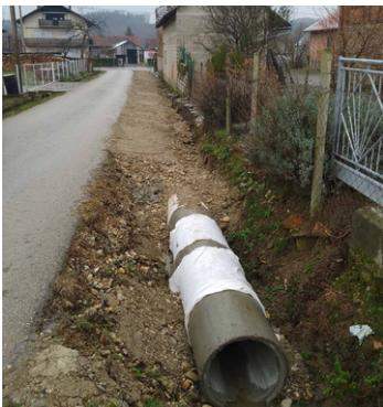
U tijeku su radovi na zacevljivanju kanala za oborinsku odvodnju u mjestu Slanje, ulica Žrtava fašizma. Također, radi se na ugradnji betonskih kanalica za oborinsku odvodnju u mjestu Vrbanovec, ulica Rudolfa Krušeca.
